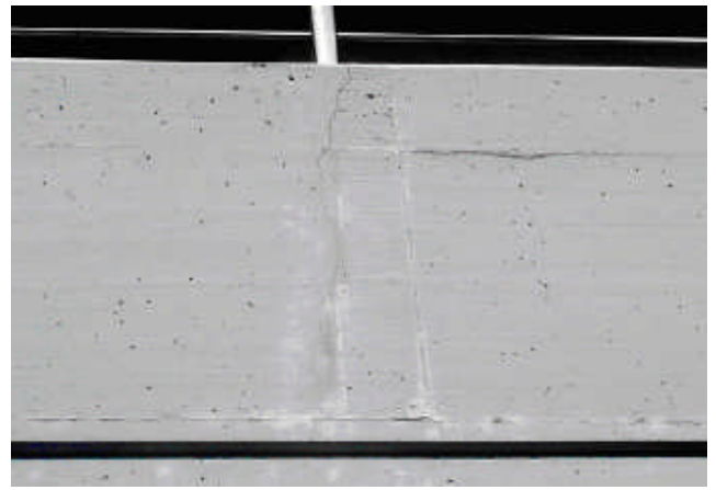
Mur en béton: l'eau pénètre dans le béton par le bas et entre par les flancs des fissures. La couche de peinture a une épaisseur inférieure à 20 \mu\text{m} .
