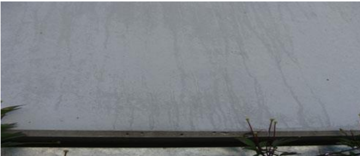
«Schnecken Spuren» auf Silikatfarben
