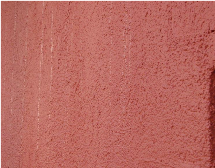
«Schnecken Spuren» auf Dispersions-Fassadenfarben
