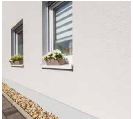
Bild 5.2: Algenfreier Spritzwasserbereich einer Fassade
