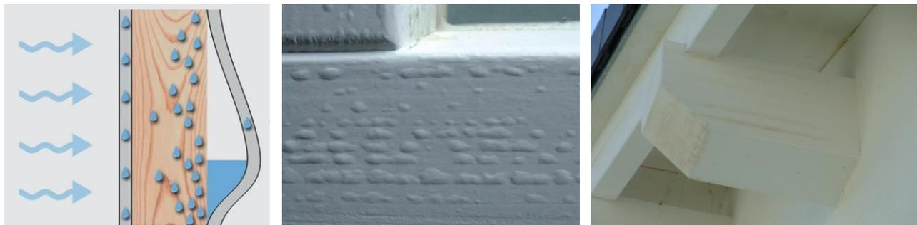
On observe également des dommages similaires sur les éléments de construction en bois qui se prolongent de l'intérieur vers l'extérieur (chevrons et poutres lamellées-collées visibles).
