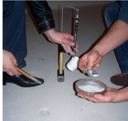
Gewinnung einer Estrichprobe für das CM-Verfahren
