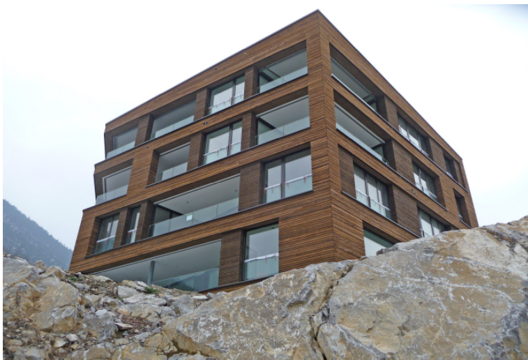
Bardage en bois autoclave, une fois traité avec d'Arbezol Aqualin teinté à l'usine
