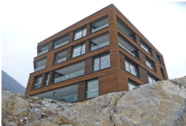
Druckimprägnierte Holzschalung, werkseitig 1x mit Arbezol Aqualin farbig im Hobelwerk beschichtet
